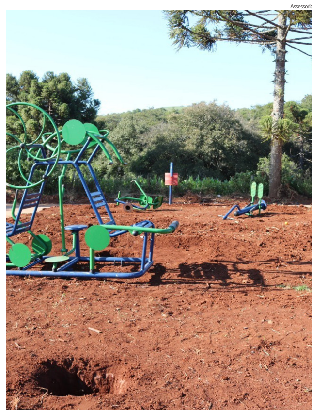
A obra atende a um pedido feito pelos moradores
